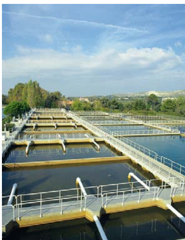
Станция очистки воды
